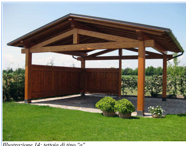
Illustrazione 14: tettoia di tipo "a"
